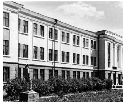
Здание Дегтярского рудоуправления
