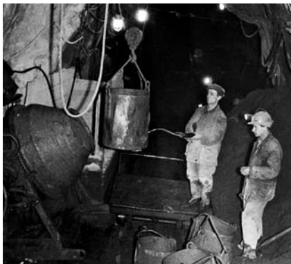
Механизация бетонных работ. 1960-е гг.
