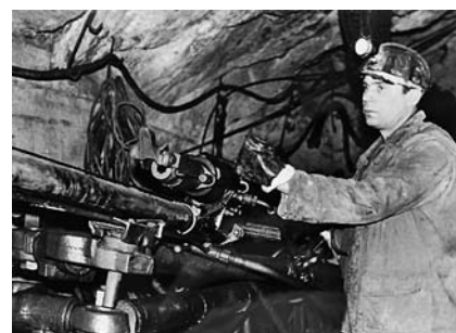
Буровая установка на проходке одного из штреков
