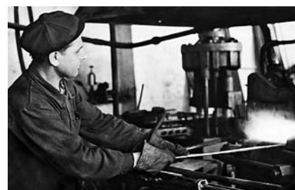
В центральном ремонтно-механическом цехе
