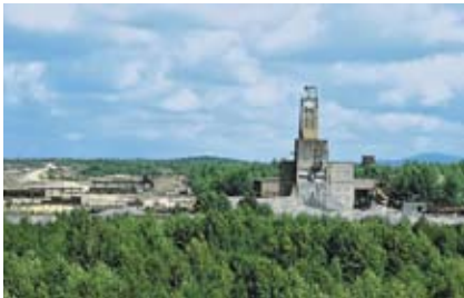
Общий вид Гумешевского рудника
