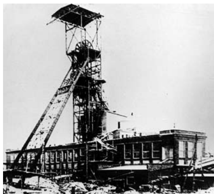
Строительство надшахтных зданий шахты «Капитальная № 2». 1937 г.
