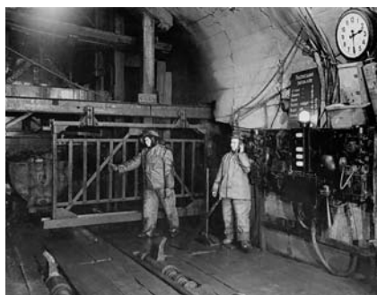
Приемочная площадка подземного горизонта (рудный двор). 1960-е гг.
