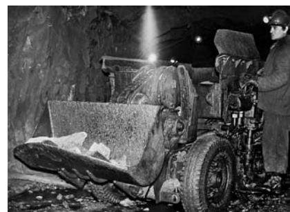
Работа на пневматической погрузочно-доставочной машине
