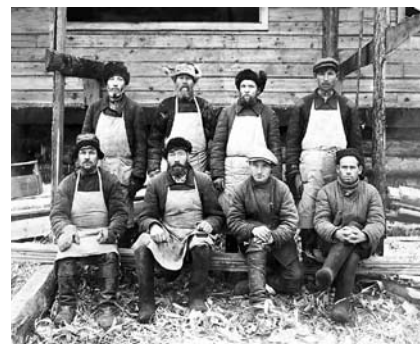
Рабочие на строительстве Дегтярского рудника. 1930-е гг.
