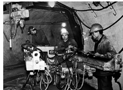
Ремонт бурового оборудования под землей
