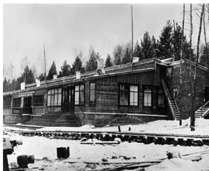
Клуб строителей Дегтярки. 1930-е гг.
