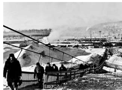
Висячий мост через обрушенную поверхность в Северной Дегтярке
